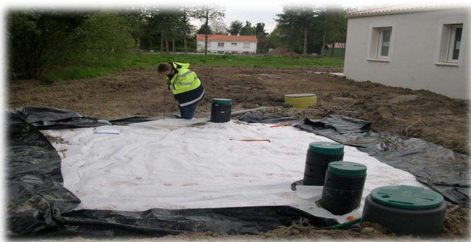
Contrôle d'un assainissement non collectif par le SPANC - Source : Site internet de La Roche sur Yon Agglomération
