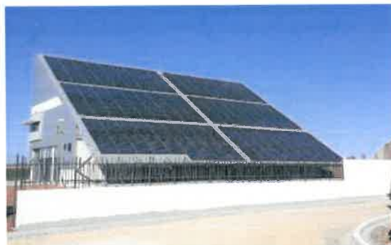
Usine d'eau potable à Luçon (85400) – 99,9 kWc installés Produit 125 150 kWh par an soit l'équivalent des besoins énergétiques de 36 foyers
