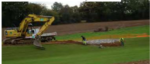
Réalisation d'un bassin de régularisation
