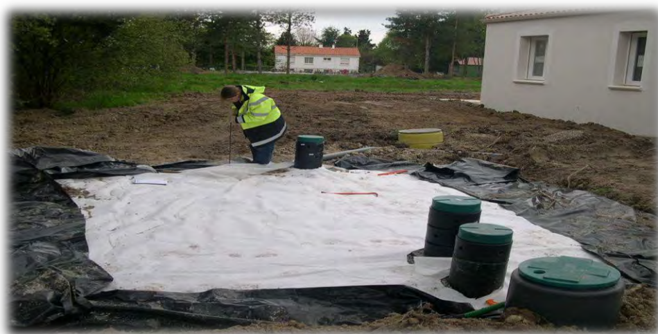
Contrôle d'un assainissement non collectif par le SPANC - Source : Site internet de La Roche sur Yon Agglomération
